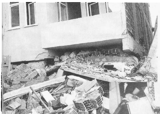
在土耳其与台湾大地震中,都存在着由于“豆腐渣”工程造成的楼房破坏
