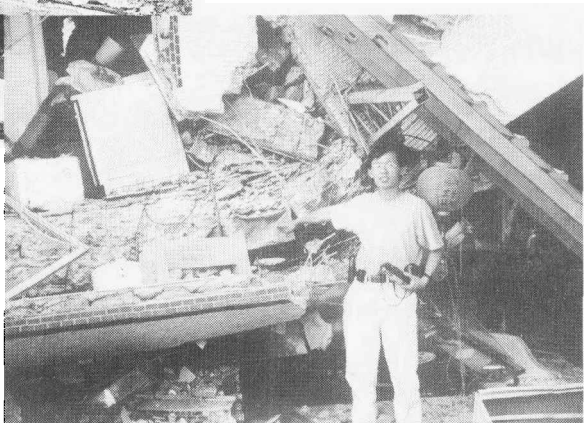
在土耳其与台湾大地震中,都存在着由于“豆腐渣”工程造成的楼房破坏
